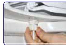
Konik rondela ile birlikte Quick Fix somunu civata üzerinde çevirmeden, pratik bir hamle ile yukarı doğru bastırılarak sıkıştırma boşluğu alınır.
